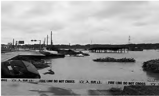
水戸市飯富地区で水害により道路が陥没
